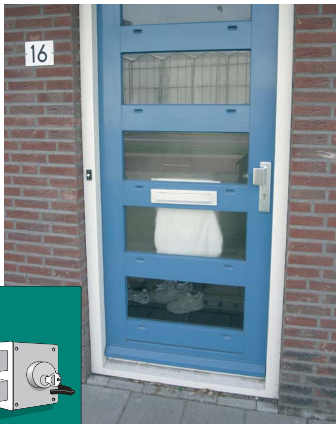
Oplegslot met cilinder en sluitkom
